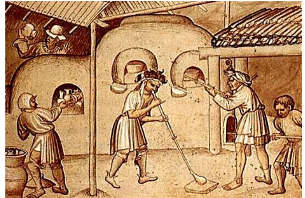
Ofen mit rechteckigem Grundriss mit zwei Kammern, rechts der Werkofen, links der Kühl-Ofen, der auch als Frittofen diente. Flämische Miniatur (Ausschnitt) aus den Reisebeschreibungen des Jean de Mandeville, um 1420. British Museum, London.
