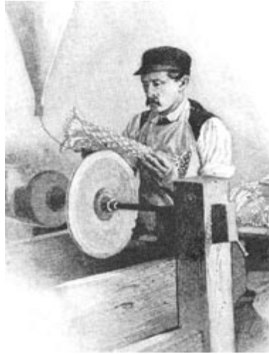
Abb. 6 Diese Zeichnung aus der Zeit um 1900 zeigt einen Glasschleifer bei der Arbeit am Kuglerstuhl mit einer keilförmig abgedrehter Schleifscheibe zum Schleifen von Keilschliffen, hier auf einer Vase. Aus dem trichterförmigen Gefäß links oben fließt durch ein Kupferröhrchen ständig Wasser auf die Scheibe, um die Reibungshitze niedrig zu halten.
